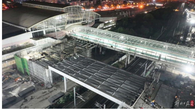
图：莘庄站上跨沪春铁路过渡天桥
