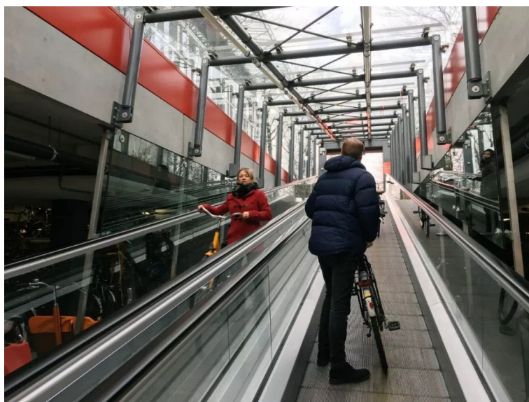
说明图7.5.2-2 北侧自行车地库的扶梯坡道
