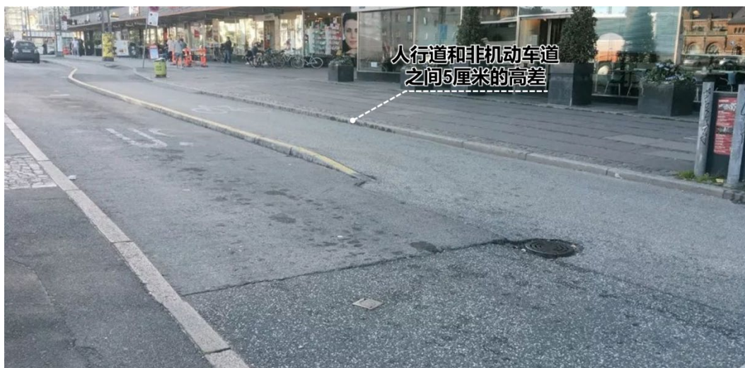
说明图7.5.2-6 非机动车道与车行道、人行道之间设置的 5 厘米的路缘石高差
